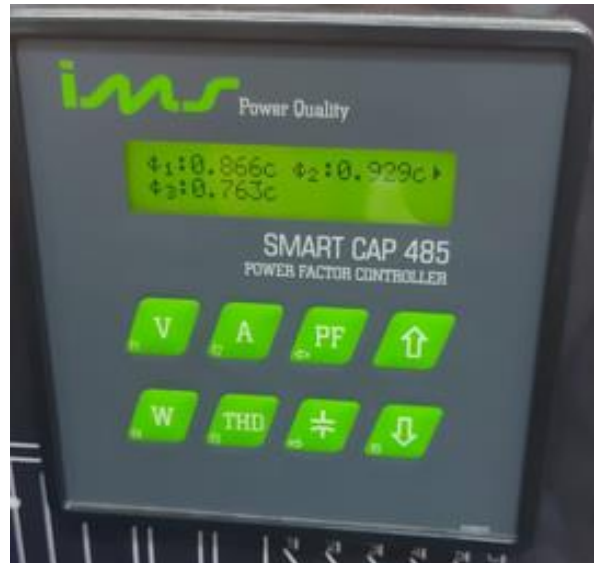
Figura 24 – Fator de potência medido no Smart Cap 485 Fonte: Arquivo pessoal dos autores
