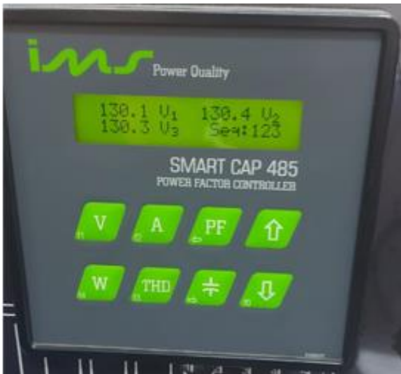
Figura 17 – Valores das tensões nas três fases Fonte: Arquivo pessoal dos autores
