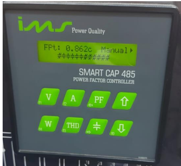
Figura 15 – Fator de potência medido no Smart Cap 485 Fonte: Arquivo pessoal dos autores
