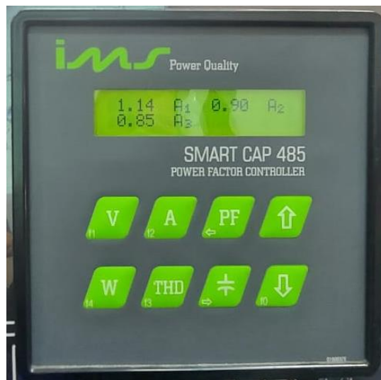
Figura 9 – Valores das correntes nas três fases Fonte: Arquivo pessoal dos autores
