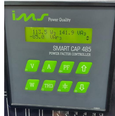
Figura 22 – Potência Ativa, Reativa e Aparente na Fase 3 Fonte: Arquivo pessoal dos autores
