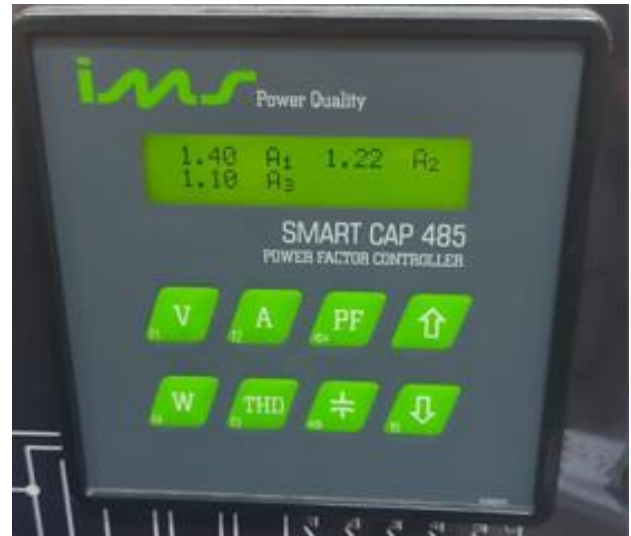
Figura 18 – Valores das correntes nas três fases Fonte: Arquivo pessoal dos autores
