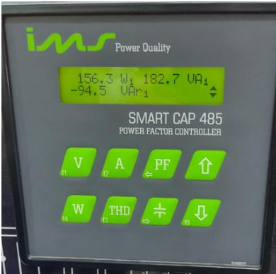
Figura 20 – Potência Ativa, Reativa e Aparente na Fase 1 Fonte: Arquivo pessoal dos autores
