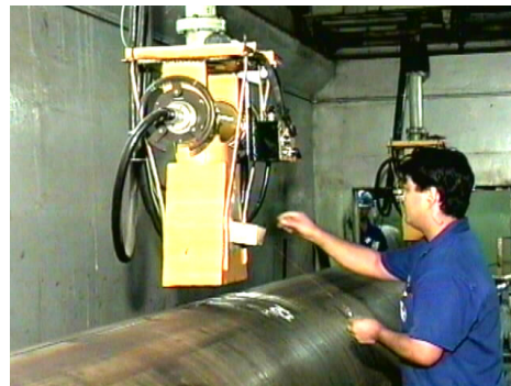
Inspeção radiográfica de soldas em tubos
