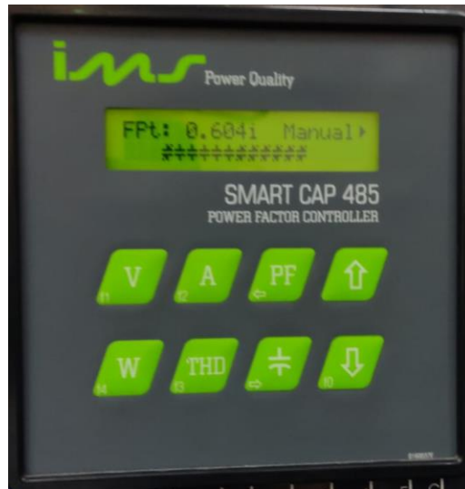
Figura 14 - Fator de potência calculado com o medido no SMART CAP 485 Fonte: Arquivo pessoal dos autores
