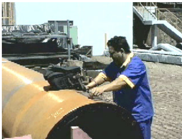
Inspeção por ultrassom da chapa de um tubo
