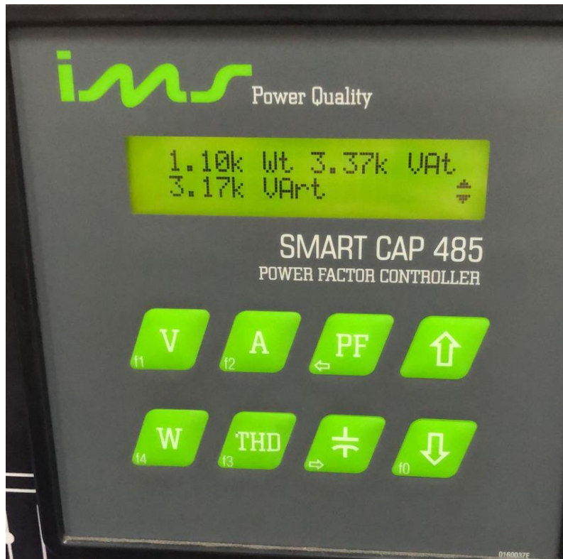
Figura 13 - Somatória das potências das três fases Fonte: Arquivo pessoal dos autores
