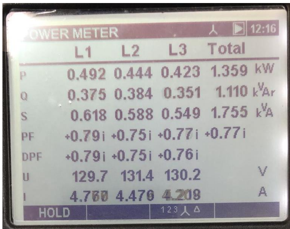
Figura 34 - Fator de potência após correção Fonte: Arquivo pessoal dos autores
