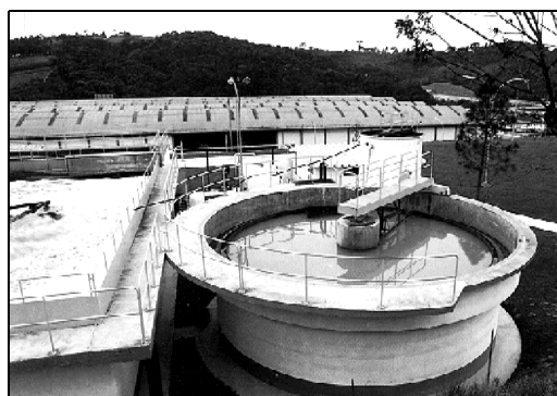
tanque de decantação
